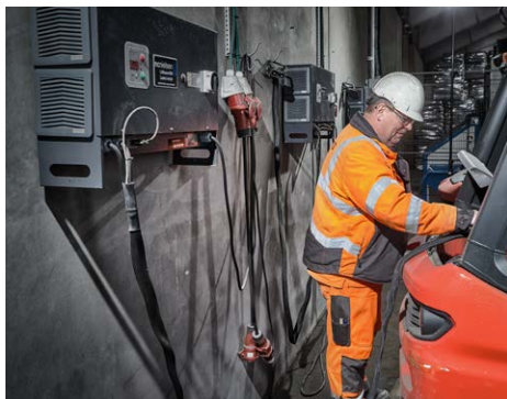
Lader-stationen hos Dansand er en ren "plug and play"-løsning, hvor truckføreren blot skal bakke trucken i boks og forbinde laderen til stikket bag på trucken.
